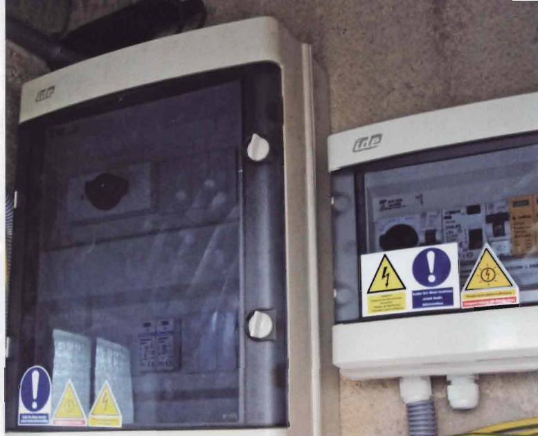
Sur ces coffrets, l'on trouve à la fois des avertissements prescrits par l'ancien guide UTE C 15-712 et le nouveau guide UTE C 15-712-1. L'affichage est donc non conforme.
